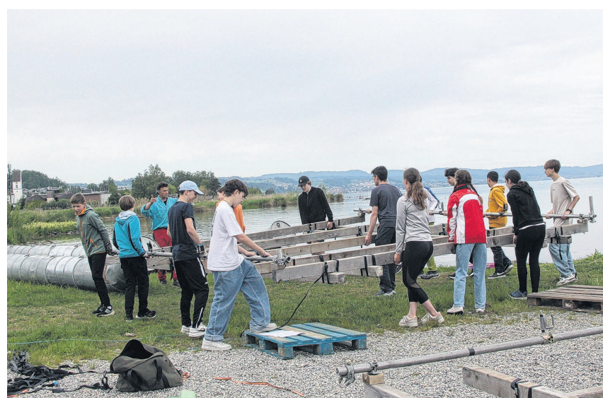
Mit vereinten Kräften wird das erste Plattformgerüst auf die Schwimmkörper aus Blechtonnen gehievt.
